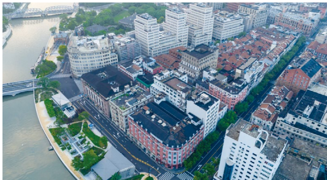
▲ 外滩源二期项目俯瞰实景图
