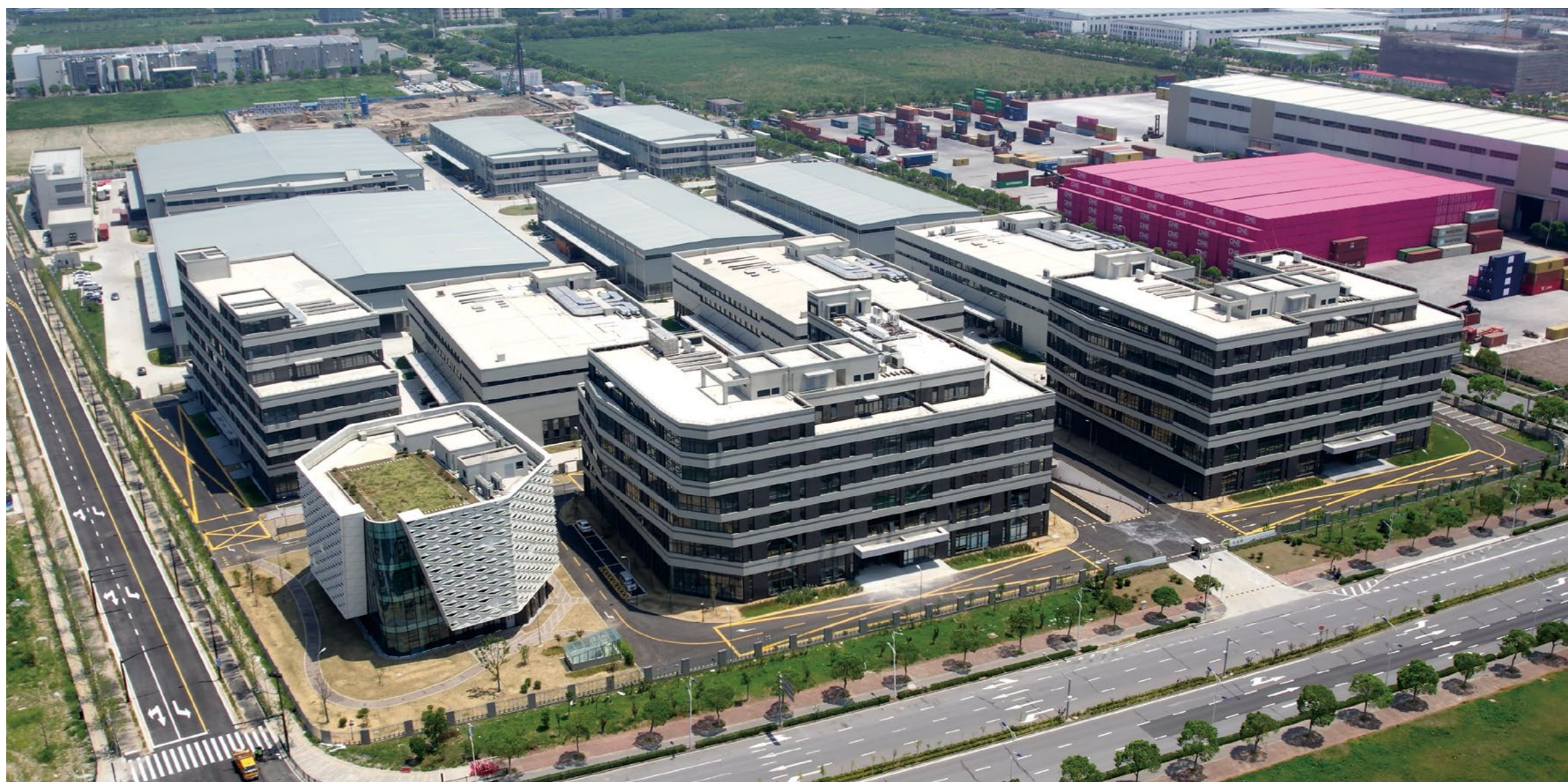
▲ 闵行开发区临港园区智芯源一期实景图
