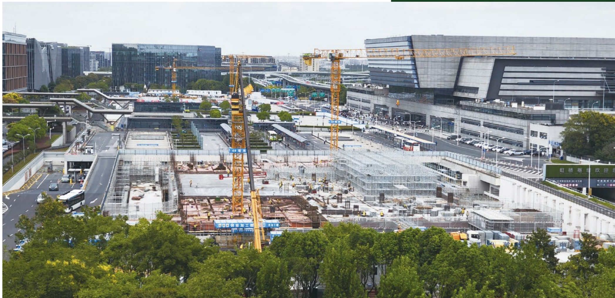
▲ 虹桥枢纽西交广场综合提升工程建设实景图
