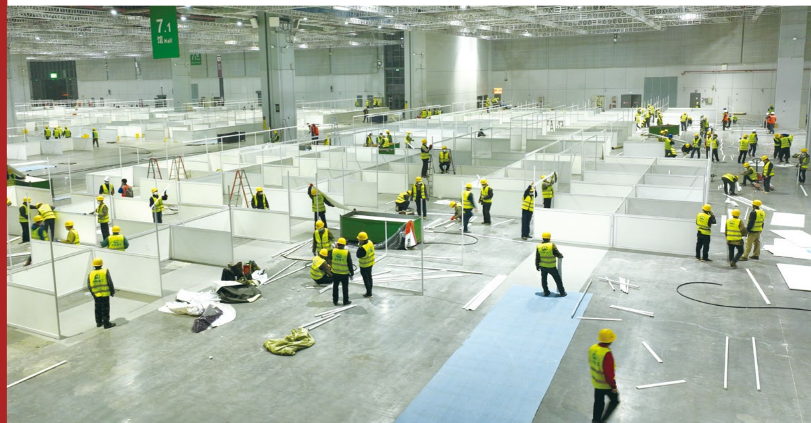
▲ 国家会展中心方舱医院建设现场
