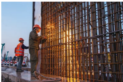
▲ 一线工人施工现场
