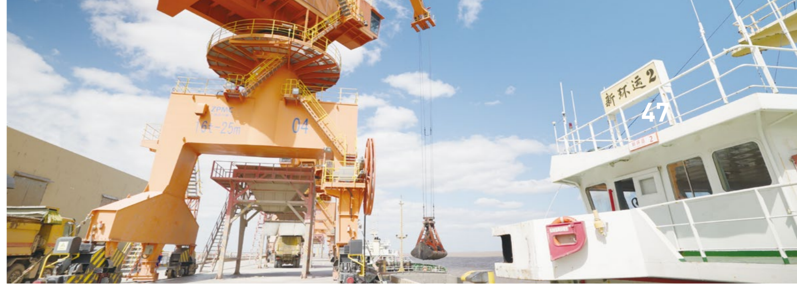
▲ 渣土消纳卸点实景图
