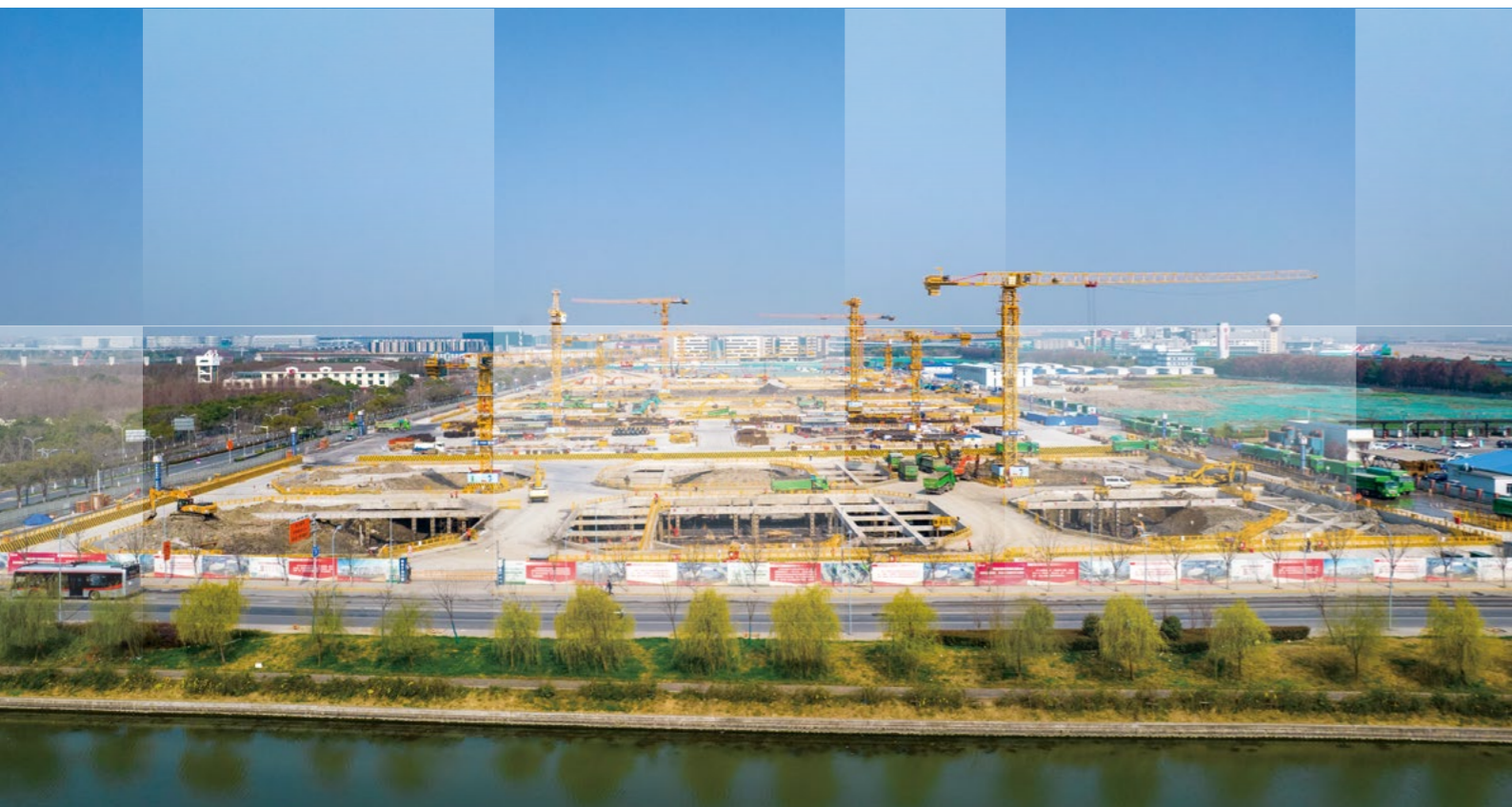
▲ 机场联络线申昆路停车场项目建设实景图
